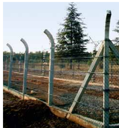
Barrière de protection physique.
