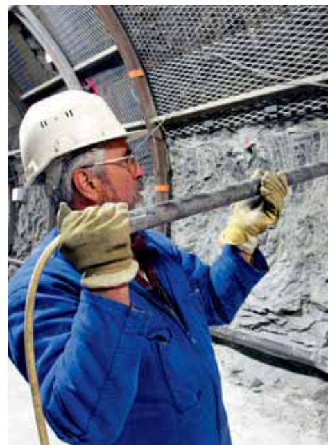
Introduction d'une instrumentation dans un forage.
