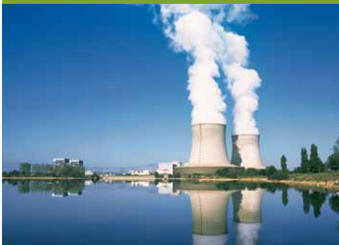
Le site de Saint-Laurent-des-Eaux. La première CLI à s'être mobilisée pour mettre en place l'action pilote menée dans le bassin de la Loire.
