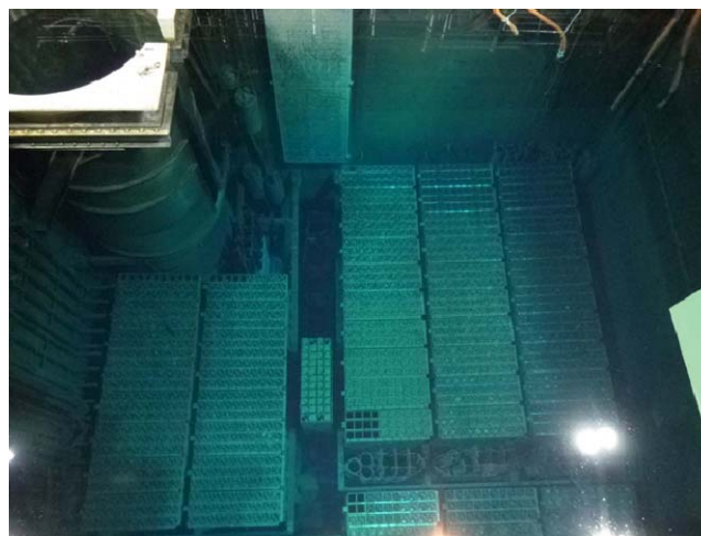
Source TEPCO - Piscine du réacteur 4 après retrait des débris
