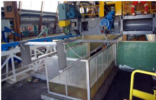
Figure 25 Mise en place dans le bassin
