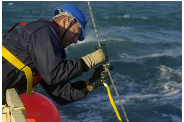
Figure 10 Fixation des tuyaux sur le câble porteur
